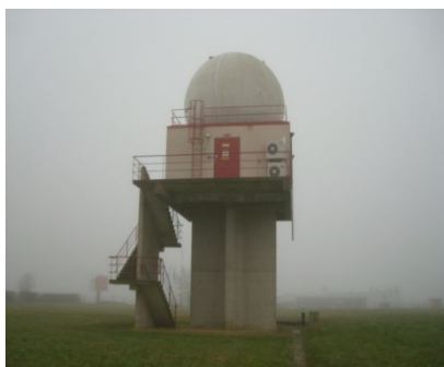
Différentes architectures de bâtiments radar, les salles techniques principales sont situées sous le radôme qui protège l'antenne, les salles techniques énergie sont au sol
