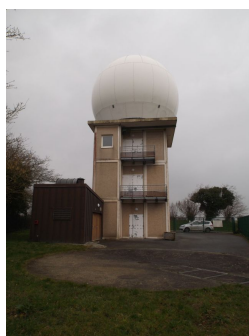
Différentes architectures de bâtiments radar, les salles techniques principales sont situées sous le radôme qui protège l'antenne, les salles techniques énergie sont au sol
