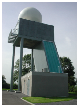
Différentes architectures de bâtiments radar, les salles techniques principales sont situées sous le radôme qui protège l'antenne, les salles techniques énergie sont au sol
