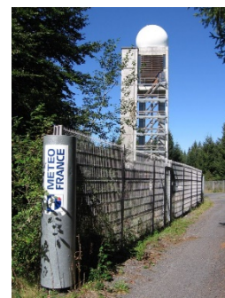
Différentes architectures de bâtiments radar, les salles techniques principales sont situées sous le radôme qui protège l'antenne, les salles techniques énergie sont au sol
